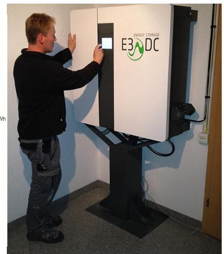
Das Batteriesystem muss bei einem Blackout/Strommangellage insel-fähig sein, d.h. die Verbindung zum LKW-Stromnetz wird getrennt und es wird ein hauseigenes 50 Hz Stromnetz aufgebaut. Die Photovoltaikanlage benötigt für die Produktion ein stabiles 50 Hz Stromnetz.
